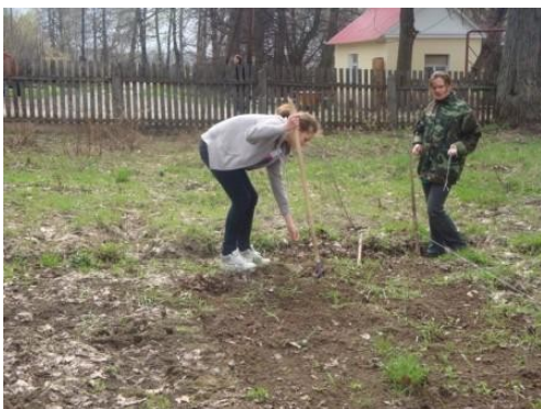
2-ой этап работы. Разметка площадки
